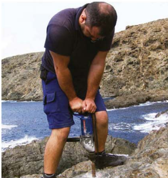
Fig. 7 - Furação na rocha para incrustação de marca de nivelamento
