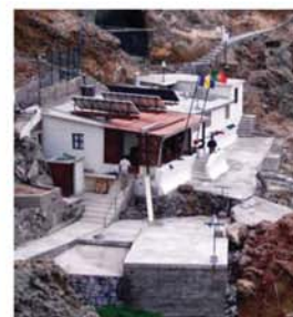
Fig. 13 - Casa dos guardas do Parque Natural da Madeira – ponto de apoio logístico para as acções em terra
