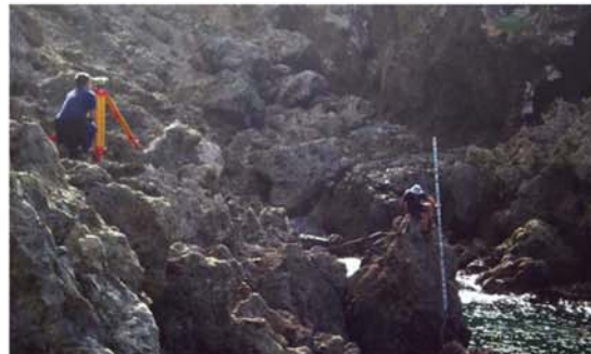
Fig. 9 - Nivelamento geométrico desde os marégrafos até à casa dos guardas do Parque Natural da Madeira
