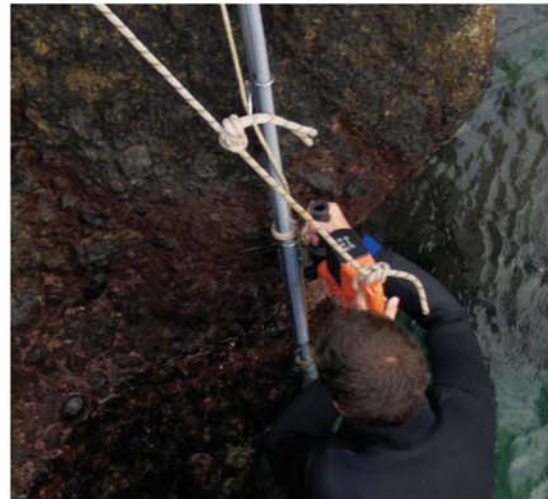
Fig. 5 - Instalação dos marégrafos de campanha
